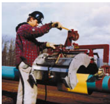
Slika 16 Zavarivanje cijevi na temperaturama ispod 0°C
