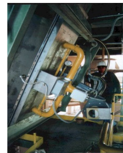
Slika 12 Predgrijavanje spremnika promjera 10.000 mm i debljine stjenke 140 mm kod zavarivanja
